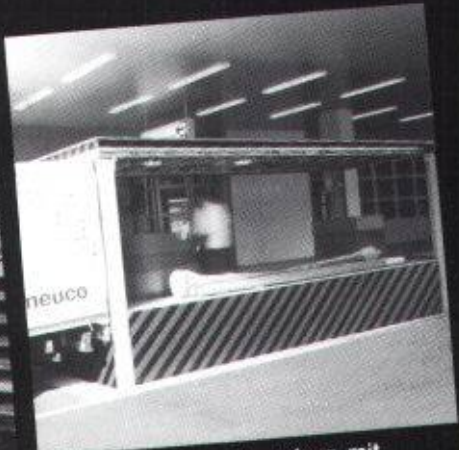
z.B. Scheren-Unterfluraufzug, mit Baldachin-Schachtabdeckung
