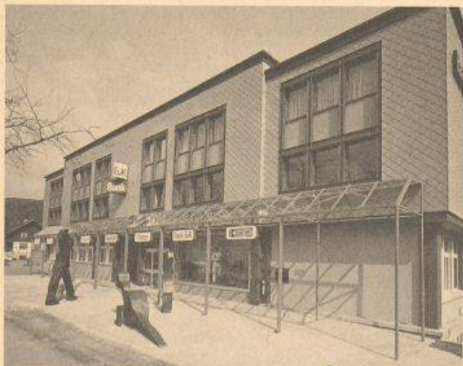
Verbund von Feuerverzinken und Farbbeschichten für ein Vordach in Metallkonstruktion. Geschäftshaus in Gümligen/Bern
