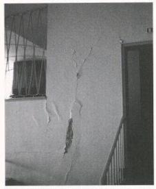
Bild 7. Schäden an Innenwand der Festhalle in Oberbruch/Heinsberg als Folge von Zwängungsbeanspruchungen
