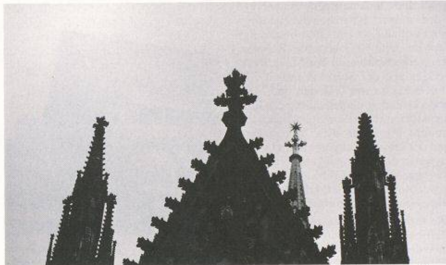
Bild 8. Schaden am Kölner Dom: Auf der Turmspitze rechts fehlt die Kreuzblume
