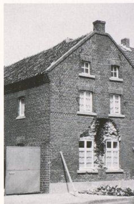
Bild 6. Beispiel für Mauerwerkschäden: Ausbruch an älterem Wohnhaus in Oberbruch/Heinsberg
