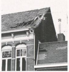
Bild 4. Beispiel für Kamin- und Dachschäden im Stadtkern von Roermond
