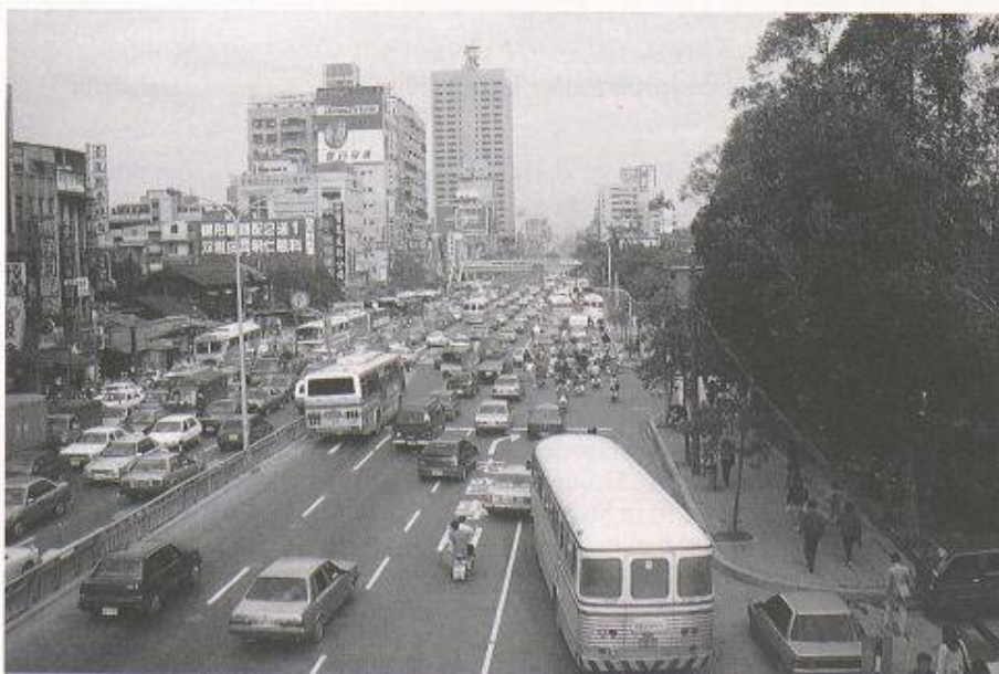
Bild 1. Verkehrssituation entlang Roosevelt Road: Beim sichtbaren Hochhaus Taipei Power Building entsteht die gleichnamige Station
