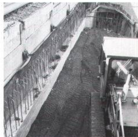
Viel Raumgewinn dank Enkadrain CK beim PTT-Neubau im Bahnhof Chur (Fotos: A.P. Hartmann, HG Commerciale)
