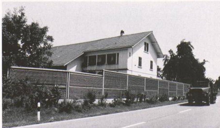
Lärmschutzwand aus Holz – umweltverträglich und ästhetisch befriedigend
