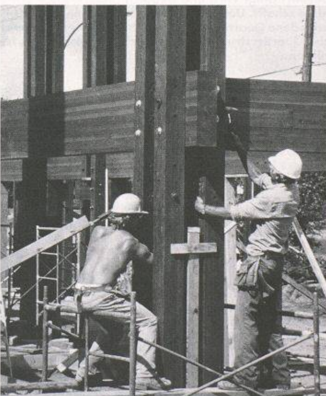
Bild 6. Mehrgeschossiges Bürogebäude mit Parallam-Stützen und Brettschichtholz-Unterzügen
