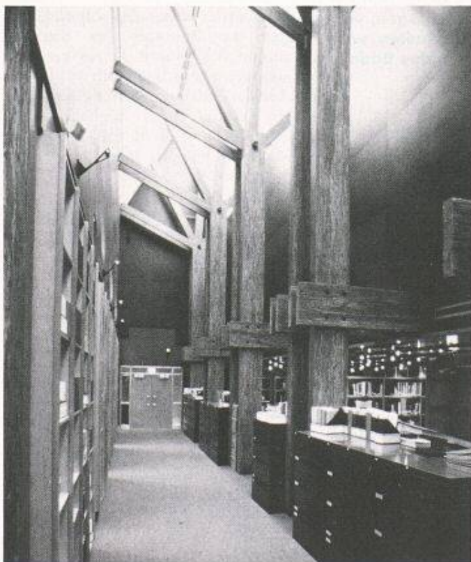
Bild 5. Parallam in einem mehrgeschossigen Forschungsgebäude
