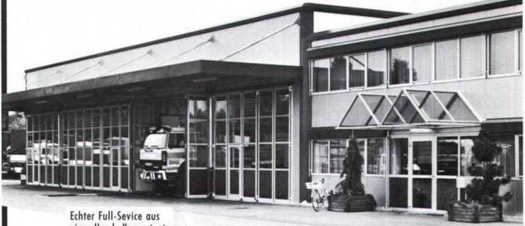
Echter Full-Sevice aus einer Hand: Kompetente Projektierung und Realisierung bis ins letzte Detail; hier Ausführung im Stampfli-Bausystem Isowand, Typ B.
