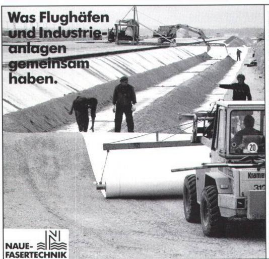
In beiden Fällen fallen grundwassergefährdende Stoffe an, die gemäss Wasserhaushaltsgesetz kontrolliert entsorgt werden müssen. Bei Flughäfen wie bei Industrieanlagen leistet BENTOFIX® – das sind faserarmierte mineralische Dichtungsmatten – hervorragende Dienste für den Umweltschutz.
