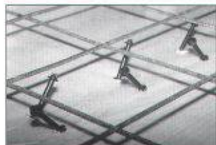
SFS-Verbund-Elemente verbessern das Tragverhalten
