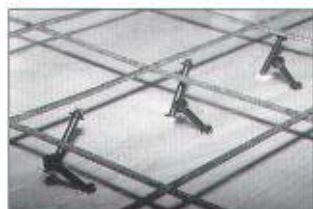
SFS-Verbund-Elemente verbessern das Tragverhalten
