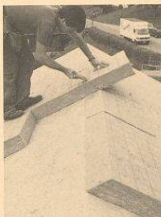
Bild 1. Verlegung Sarnaroc Nova, Bearbeitung am First
