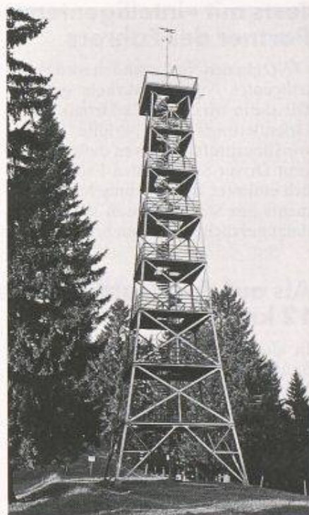
Der hundertjährige Bachtelturm (im Bild noch am alten Standort) wird zurzeit auf dem Pfannenstiel wieder aufgebaut
