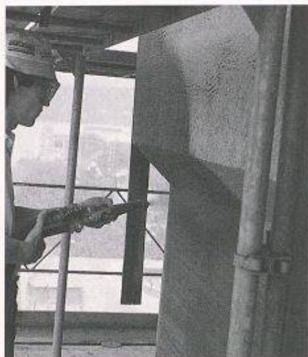
Maschinelle Applikation des Reprofiliermörtels Sika Mono Top 615 bei grossflächiger Anwendung
