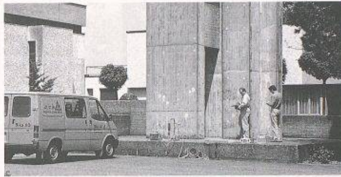
Messung der Eisenüberdeckung im Rahmen der Zustandsanalyse
