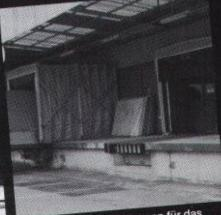
z.B. Spezial-Torabdichtungen für das seitliche oder rückwärtige Andocken von Lkws und Waggons.
