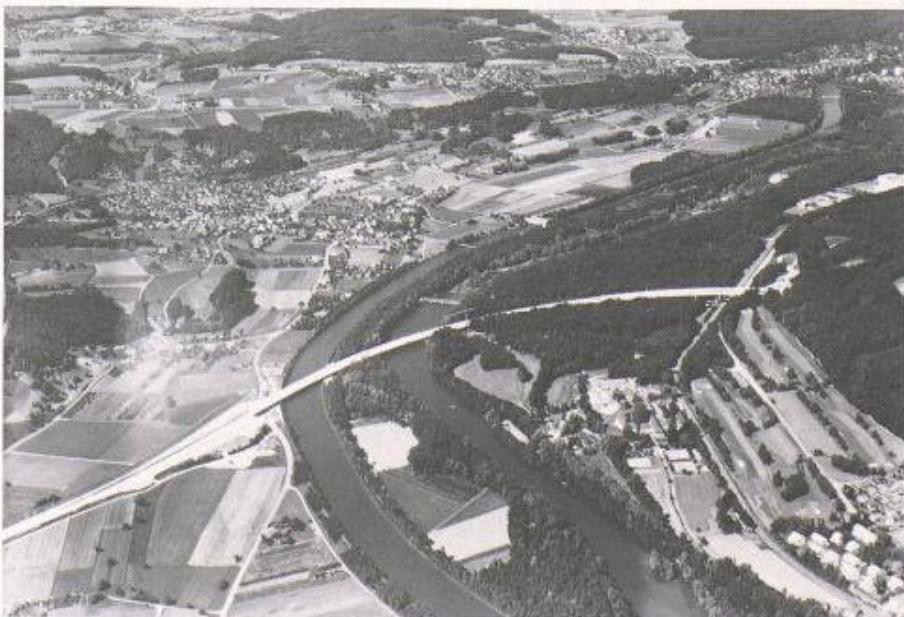
Eine Lücke der N3 wird bald geschlossen sein. Die Aaretalbrücke ist im Rohbau fertiggestellt (Bild. Comet)
