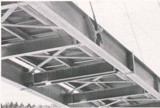
Bild 5. Untersicht mit Seilverankerung und Elementstoss
