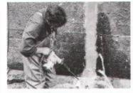
Bei Umbauten/Sanierungen gehören Injektions-Abdichtungen und -Verfestigungen praktisch immer zu den zentralen Massnah-
