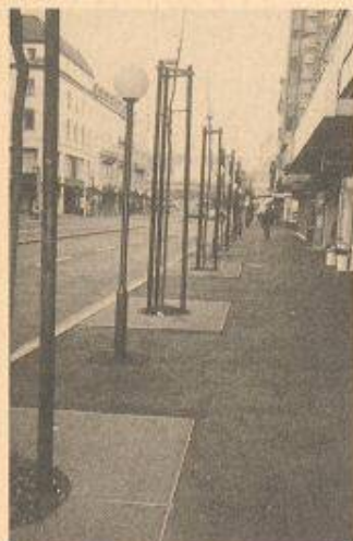
Arconda-Baumschutzsystem aus Beton (Löwenstrasse, beim Hauptbahnhof Zürich)
