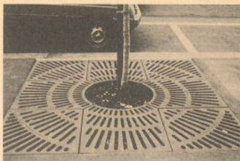
Guss-Abdeckrost mit runder Baumöffnung
