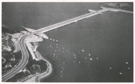
Bild 2. 240 MW-Gezeitenkraftwerk an der Rancemündung in Frankreich. Blick vom Becken Richtung Meer; links die Schiffsschleuse; in der Mitte das Maschinenhaus; rechts das Wehr (Bild EdF)
