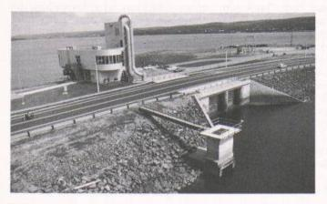
Bild 3. 20 MW-Pilotanlage Annapolis an der Bay of Fundy, Kanada. Blick vom Meer Richtung Becken; Maschinenhaus und Kommandoraum (Bild Sulzer-Escher Wyss)
