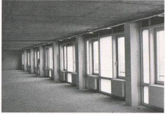
Bild 6. Transparente Isolation zur Tageslichtnutzung im Technologiepark Düsseldorf
