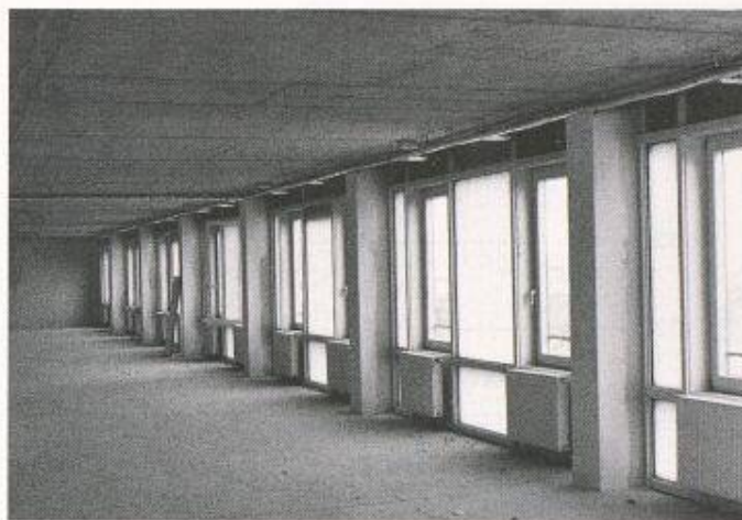
Bild 6. Transparente Isolation zur Tageslichtnutzung im Technologiepark Düsseldorf
