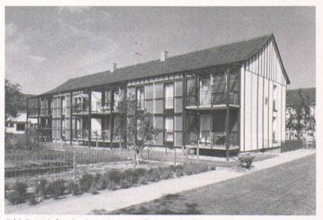
Bild 5. Mehrfamilienhaus Sonnenäckerweg, Freiburg (BRD) mit 120 m² passiver TI-Fassade (Foto: Fraunhofer Institut für Solare Energiesysteme, Freiburg (BRD))
