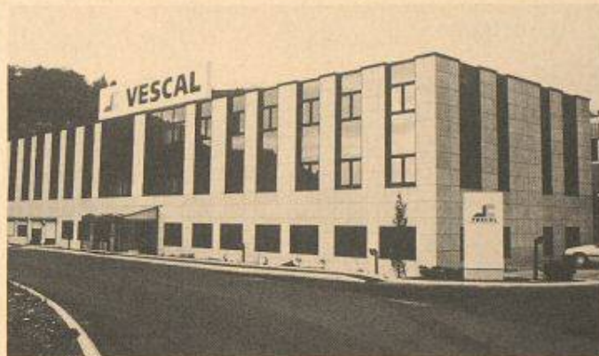
Das neue Verwaltungsgebäude der Vescal AG in Vevey/St-Légier
