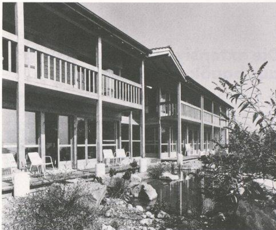
Bild 6. Wohnhaus in St. Niklausen (Architekt: Paul Roos). Auf drei Seiten Mauern aus Backstein mit möglichst wenigen Fenstern, gegen Süden geöffnet der eingeschobene reine Holzbau aus Fichtenholz.
