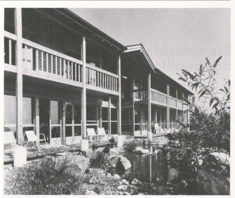
Bild 6. Wohnhaus in St. Niklausen (Architekt: Paul Roos). Auf drei Seiten Mauern aus Backstein mit möglichst wenigen Fenstern, gegen Süden geöffnet der eingeschobene reine Holzbau aus Fichtenholz
