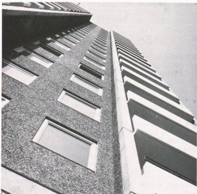
Bild 4. 22geschossiges Hochhaus in Hannover/Laatzten aus dem Jahre 1974
