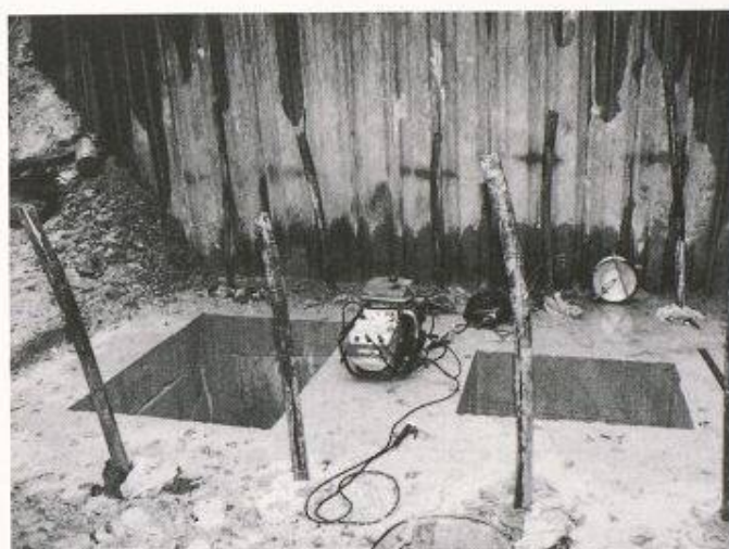
Bild 8. Köcherfundament mit Litzenankern
