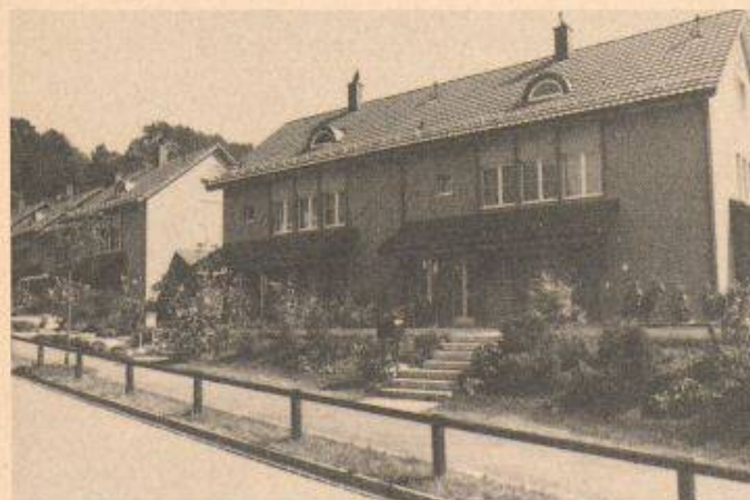
Bei der Wohnsiedlung in Freienstein ZH wird mittels Integral-Wärmepumpen die Erdwärme genutzt
