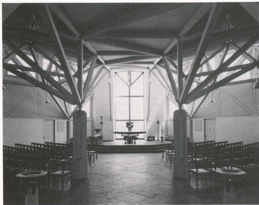
Bild 3. Holzraumfachwerk (Übersicht)
