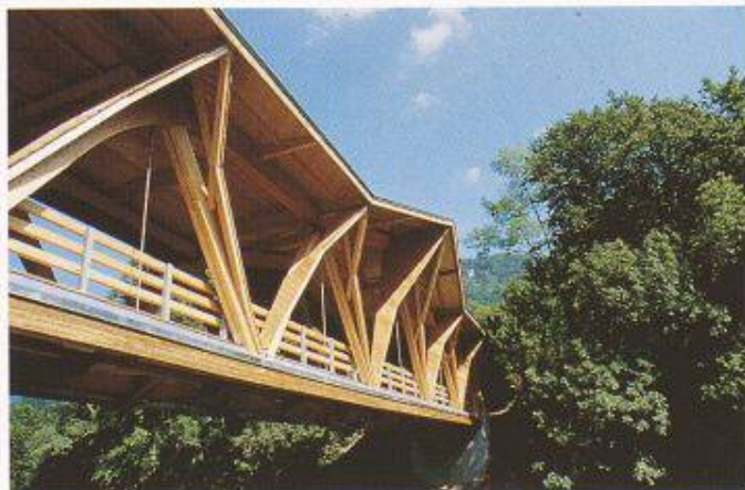
Bild 7. Die dem Wetter ausgesetzten Teile der Konstruktion sind mit einer Lärchenschalung oder mit Bleck abgedeckt. Der äussere Teil des zweiteiligen Untergurtes ist ausserdem druckimprägniert
