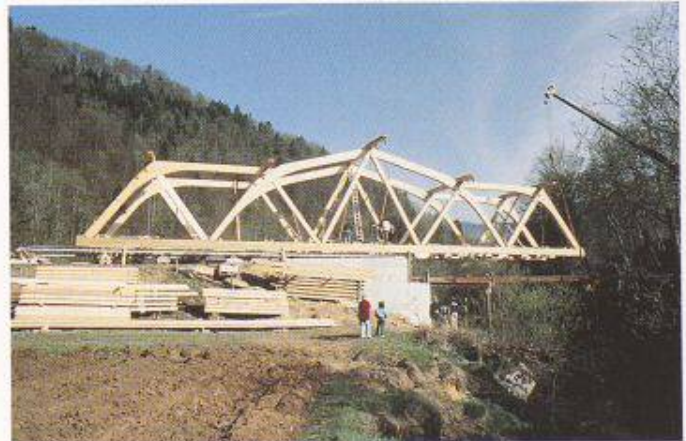
Bild 8. Das Haupttragwerk wurde neben dem Fluss auf Stahlprofilen vormontiert und auf Gleitlagern eingeschoben. Der vordere Teil der Brücke ist an einem Autokran aufgehängt
