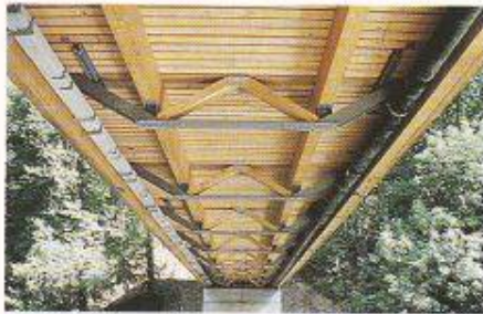
Bild 4. Untersicht der Fahrbahnplatte bestehend aus unterspannten Querträgern, sekundären Längsträgern und Balkenlage
