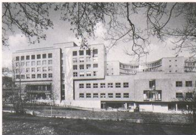
Gegen den Schanzengraben und den früheren botanischen Garten öffnet sich der riesige Gebäudekomplex etwas mit teilweise zurückgesetzten Obergeschossen (Bilder: P. Morf)
