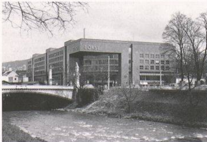
Der Eingangsbereich zur neuen Börse liegt gegenüber der Stauffacherbrücke an der Sihl. Hier liegt ganz rechts das Gelände des ehemaligen Bahnhofes Selnau, auf dem eine Wohnüberbauung entstehen soll
