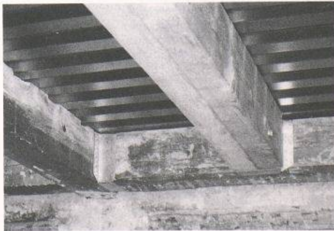
Bild 3. Holzbalken und Trapezbleche von unten gesehen
