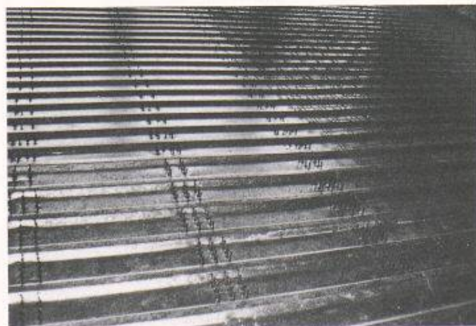
Bild 2. Trapezbleche und Verbundschrauben von oben gesehen
