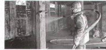
Zur Reprofilierung und strukturellen Verstärkung des Bauwerkes wird bei Renesco auch das Spritzbeton- und Spritzmörtel-Verfahren eingesetzt.
