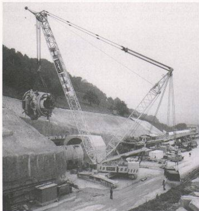
Einsatz des Raupenkranes beim Umbau der Tunnelbohrmaschine an der N3-Baustelle am Bözberg: Der 120-t-Erektor (Gerät zum Versetzen der Tübbing) der TBM wird montiert. Rechts vom Kran hängt über dem Boden das 70 t schwere Superlift-Zusatzgewicht (Bilder: Fanger, Sachseln/Luzern)
