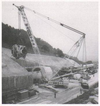
Einsatz des Raupenkrans beim Umbau der Tunnelbohrmaschine an der N3-Baustelle am Bözberg: Der 120-t-Erektor (Gerät zum Versetzen der Tübbinge) der TBM wird montiert. Rechts vom Kran hängt über dem Boden das 70 t schwere Superlift-Zusatzgewicht (Bilder: Fanger, Sachseln/Luzern)
