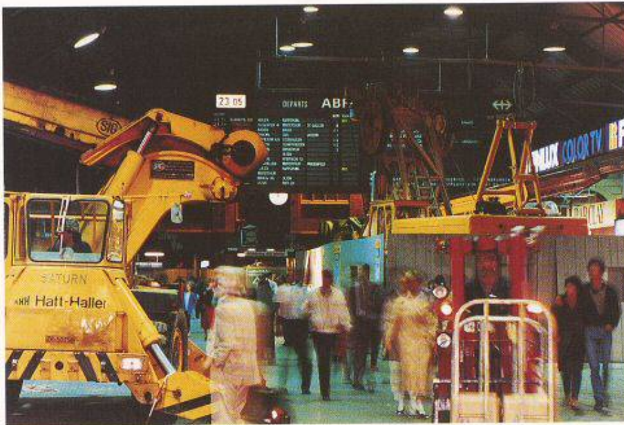
Bild 2. Baustelleninseln in Wirklichkeit, Sommer 1986
