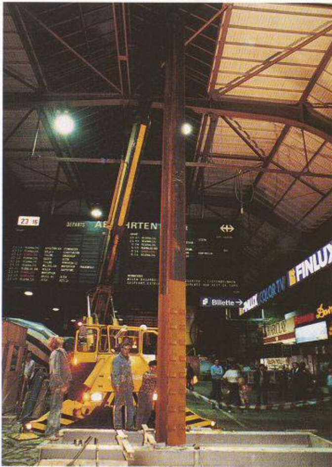
Bild 5. Halle West, Nordfassade: Abfangung der Zwischenpfeiler, April 1989
