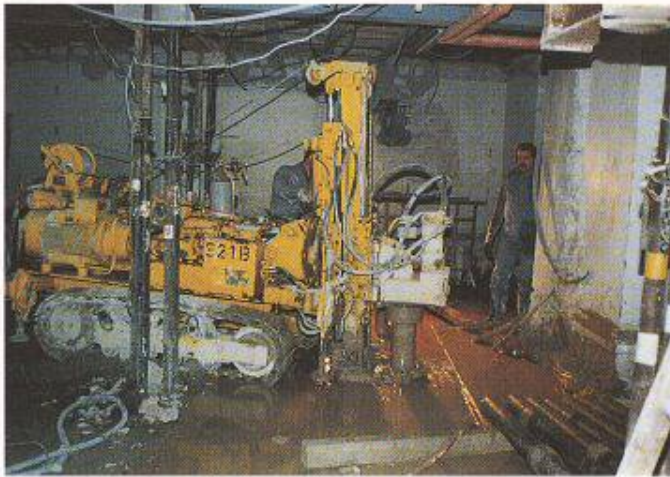
Bild 4. Herstellen der Kleinbohrpfähle im 1. Untergeschoss (lichte Arbeitshöhe: 2,5 m). Diese Kleinbohrpfähle tragen im Bauzustand die neue Bodenplatte des 1. Untergeschosses (= Decke der Passage Bahnhofstrasse)
