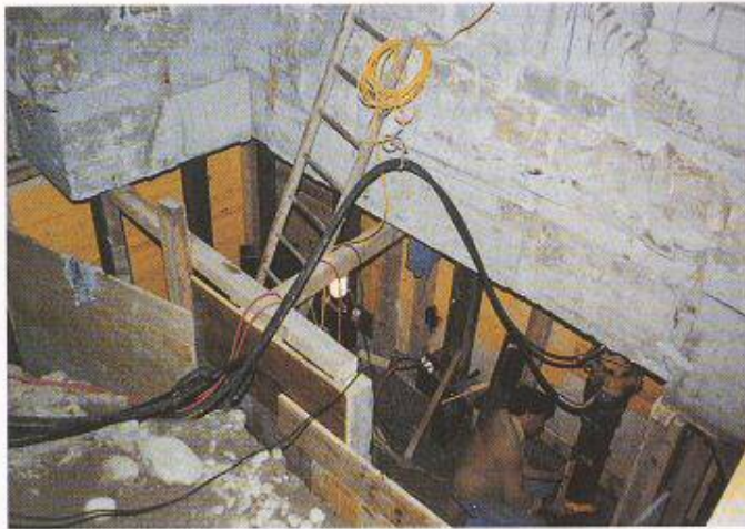
Bild 2. Unterfangen der Pfeiler- und Wandfundamente mit Presspfählen
