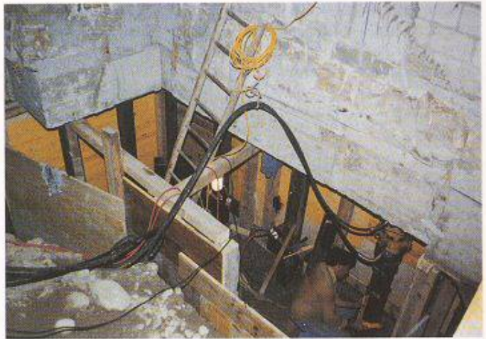
Bild 2. Unterfangen der Pfeiler- und Wandfundamente mit Presspfählen
