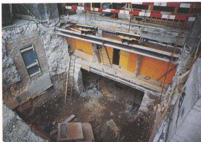
Bild 8. Blick vom Bahnhofplatz hinunter in den Anschlussbereich der Passage Bahnhofstrasse an das Shop-Ville. Oben: Stahlträger zur Abfangung der Decke des 1. UG (= Boden der Querhalle Süd), Mitte: neue Bodenplatte des 1. UG (= Decke der Passage), unten: Passage Bahnhofstrasse, «Endportal» des unterirdisch («bergmännisch») erstellten Teilstückes
