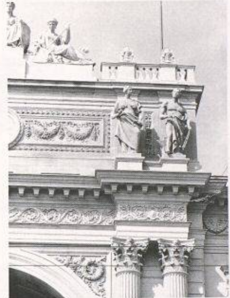
Bild 9. Detailansicht Hauptportal (Bild: S.K.M.). Restauriert 1977-80
