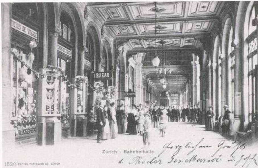
Bild 8. Ansicht der ehemaligen Wandelhalle Seite Bahnhofplatz (Bild: Baugeschichtliches Archiv der Stadt Zürich). Die Öffnung und Restaurierung der Vorhalle wird von den SBB angestrebt
