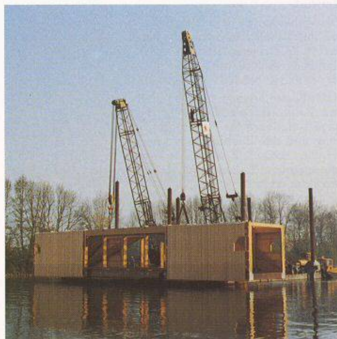
Bild 4. Aarebrücke bei Büren a.A., knappe Platzverhältnisse zwingen zur Entwicklung neuer Verbindungsmittel und zu einer unkonventionellen Montageweise.
