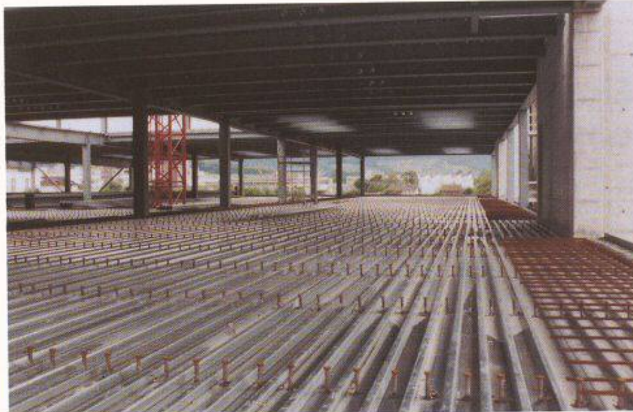
Bild 4. Zwischengeschossboden einer Haupthalle vor dem Betonieren
