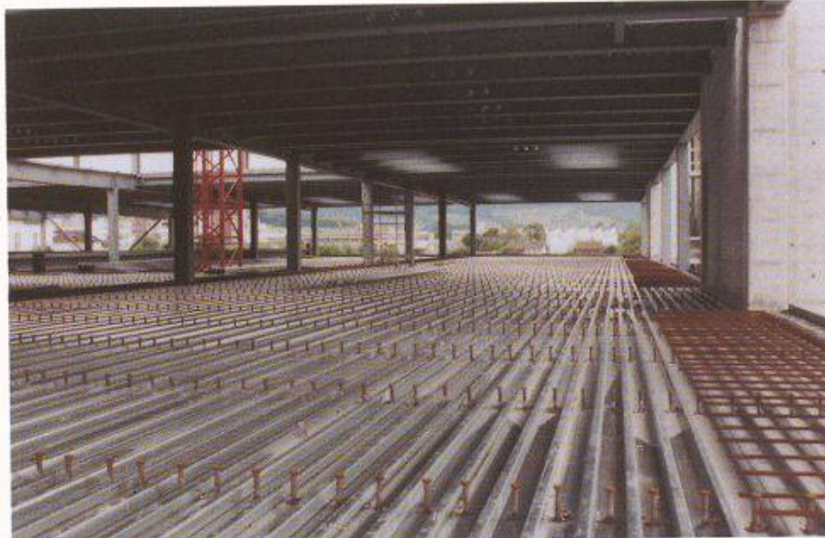
Bild 4. Zwischengeschossboden einer Haupthalle vor dem Betonieren
