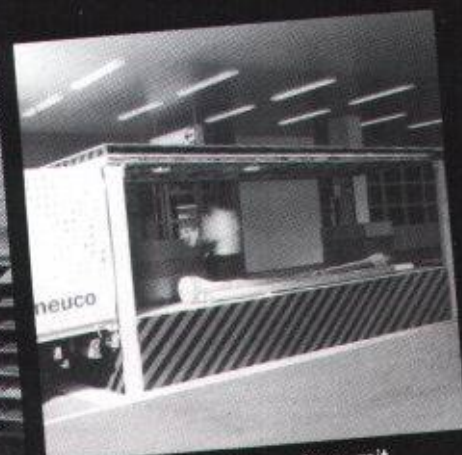
z. B. Scheren-Unterfluraufzug, mit Baldachin-Schachtabdeckung
