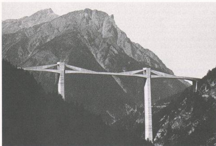
Bild 6. Ganterbrücke nach Instandsetzung des 700 m langen, salzgeschädigten Brückentroges mit Spritzbeton (Teichert)
