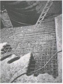
Bild 2. Betonteilausbruch mit Hochdruckwasser ohne Schädigung der Bewehrung (Rosa)
