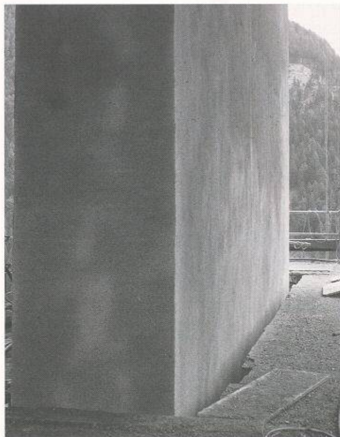
Bild 5. Grossflächige Instandsetzung eines Brückenpfeilers mit Nassspritzbeton bei hohem Chloridgehalt im Altbeton (Lukas/Kusterle)
