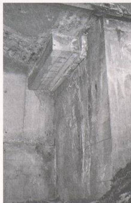
Bild 4. Brückenpfeiler mit starken Korrosionsschäden infolge Chloridangriffs (Lukas/Kusterle)
