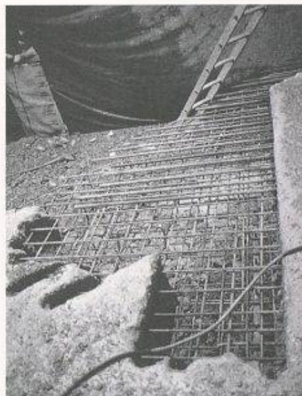
Bild 2. Betonteilausbruch mit Hochdruckwasser ohne Schädigung der Bewehrung (Rosa)
