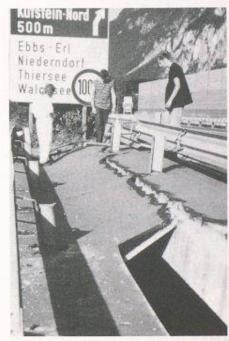
Bild 1. Inntalbrücke bei Kufstein nach dem Schadensfall
