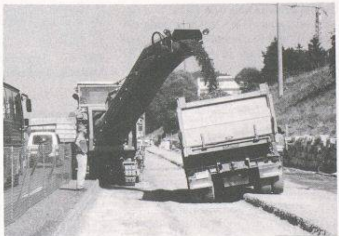
Bild 11. a) Mikrobiologische Bodenreinigung, b) Gewinnung von Recycling-Material im Strassenbau (N1 bei Zürich)
