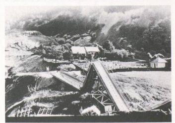
Bild 14. N2 bei Eptingen; Rutschung (1969). a) Rutschfläche: Hangschutt auf Tonfels; b) Schaden an der Dienstbrücke
