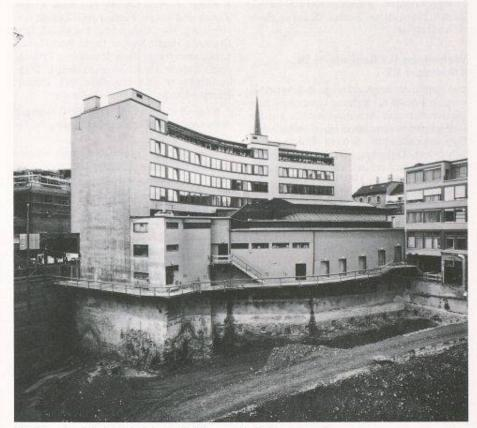
Bild 8. Bereich PAX-Gebäude: Freilegen der Soilcreteunterfangung
