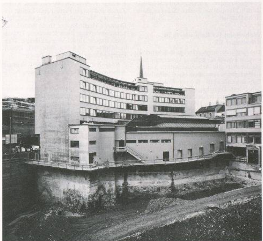
Bild 8. Bereich PAX-Gebäude: Freilegen der Soilcreteunterfangung
