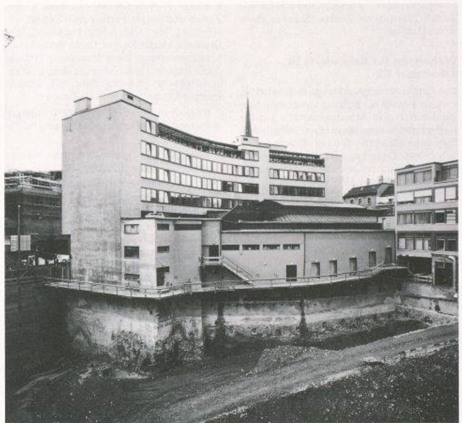
Bild 8. Bereich PAX-Gebäude: Freilegen der Soilcreteunterfangung
