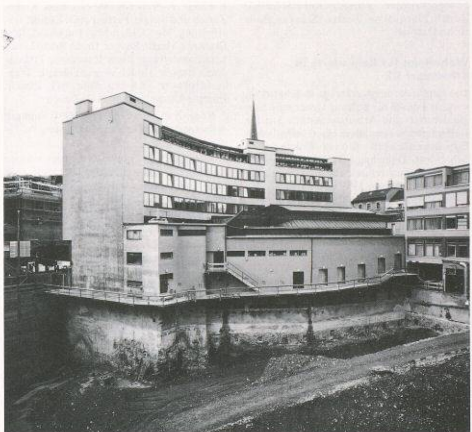
Bild 8. Bereich PAX-Gebäude: Freilegen der Soilcreteunterfangung
