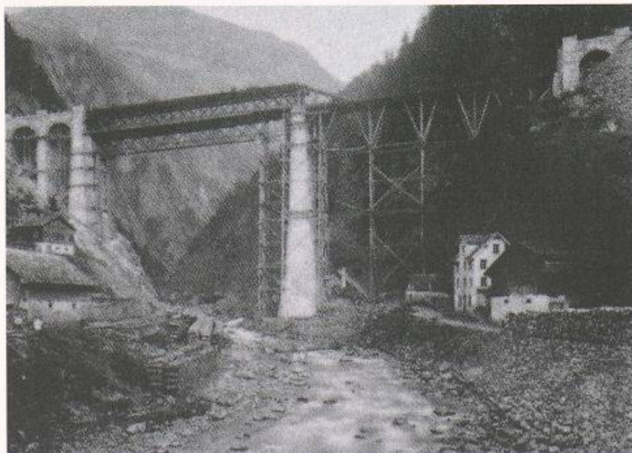
Bild 6. Bau der Kerstelenbachbrücke 1880
