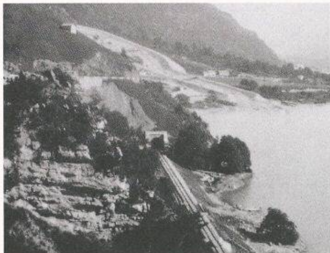
Bild 8. Mit dem Bau zahlreicher Fluss-verbauungen musste die Bahnlinie vor der zerstörerischen Kraft des Wassers geschützt werden. Diese Bauwerke erforderten zum Teil markante Eingriffe in die Landschaft
