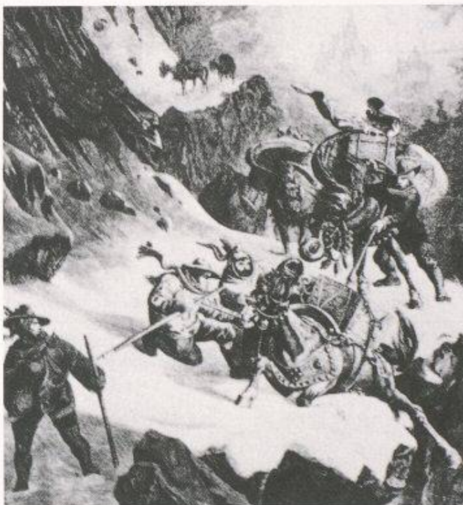
Bild 5. Schnee und Kälte stellen nicht nur an die Erbauer, sondern auch an die Benutzer der Verkehrswege hohe Anforderungen
