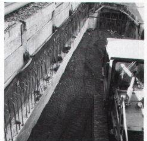
Viel Raumgewinn dank Enkadrain CK beim PTT-Neubau im Bahnhof Chur (Fotos: A.P. Hartmann, HG Commerciale)
