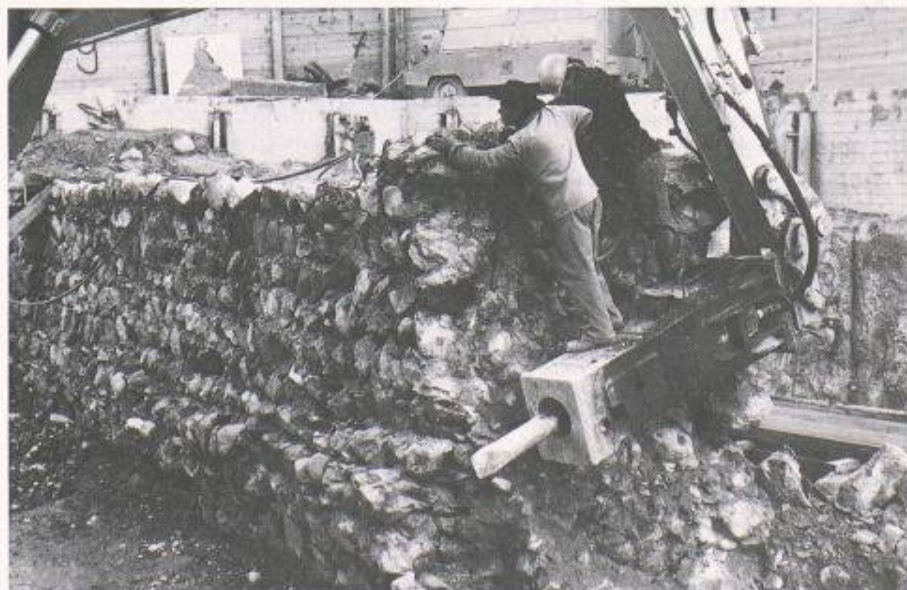
Dem Abbruch der alten Stadtmauerreste von Zürich, die beim Aushub für den Neubau der Zentralbibliothek zutage kamen, ging 1990 eine heftige Kontroverse voraus (Bild: Comet)
