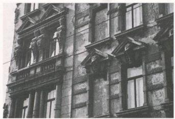
Bild 3. Zerfallende Hausfassade und entsprechend Einsturzgefahr
