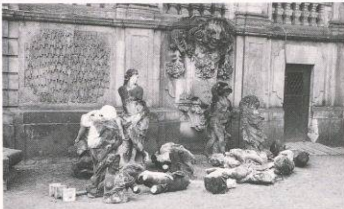
Bild 4. Steinkrebs: nicht Kriegsfolgen, sondern eine unglaubliche Luftverschmutzung führten zu diesen Zerstörungen im berühmten Dresdner Zwinger. Wertvolle Bausubstanz in der ganzen ehemaligen DDR, sofern sie den Krieg und spätere ideologisch motivierte Abbrüche überlebt hatte, ist nun durch Umweltschäden bedroht
