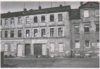
Bild 2. Mangel an Unterhalt infolge unrealistisch tiefer Mietzinse hat einen beispiellosen Zerfall der Bausubstanz bewirkt. Undichte Dächer lassen zunächst die oberen Geschosse unbewohnbar werden; mit der Zeit schreitet die Aushöhlung weiter nach unten fort, bis schliesslich der ganze Bau aufgegeben werden muss
