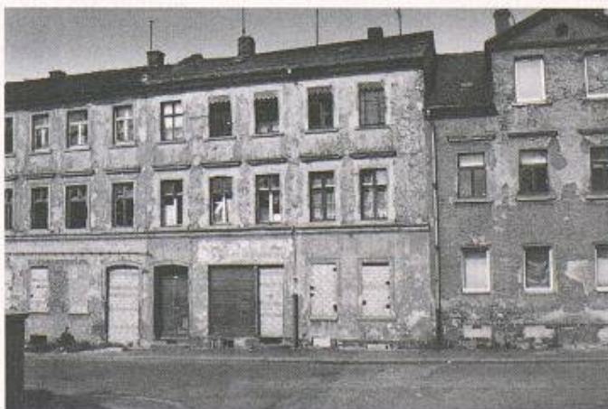
Bild 2. Mangel an Unterhalt infolge unrealistisch tiefer Mietzinse hat einen beispiellosen Zerfall der Bausubstanz bewirkt. Undichte Dächer lassen zunächst die oberen Geschosse unbewohnbar werden; mit der Zeit schreitet die Aushöhlung weiter nach unten fort, bis schliesslich der ganze Bau aufgegeben werden muss
