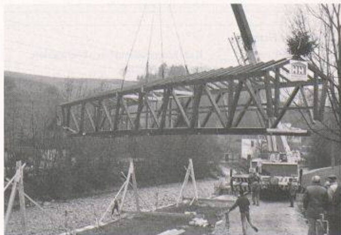
Bild 2. Absetzen des weitgehend vormontierten Tragwerkes auf den Widerlagern
