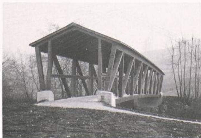
Bild 1. 24 m lang, 3 m breit und 7,5 t schwer ist die neue Fadenbrücke über die Engelbergeraas
