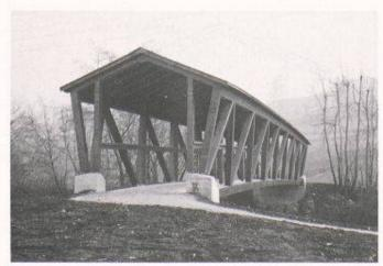
Bild 1. 24 m lang, 3 m breit und 7,5 t schwer ist die neue Fadenbrücke über die Engelbergeraa
