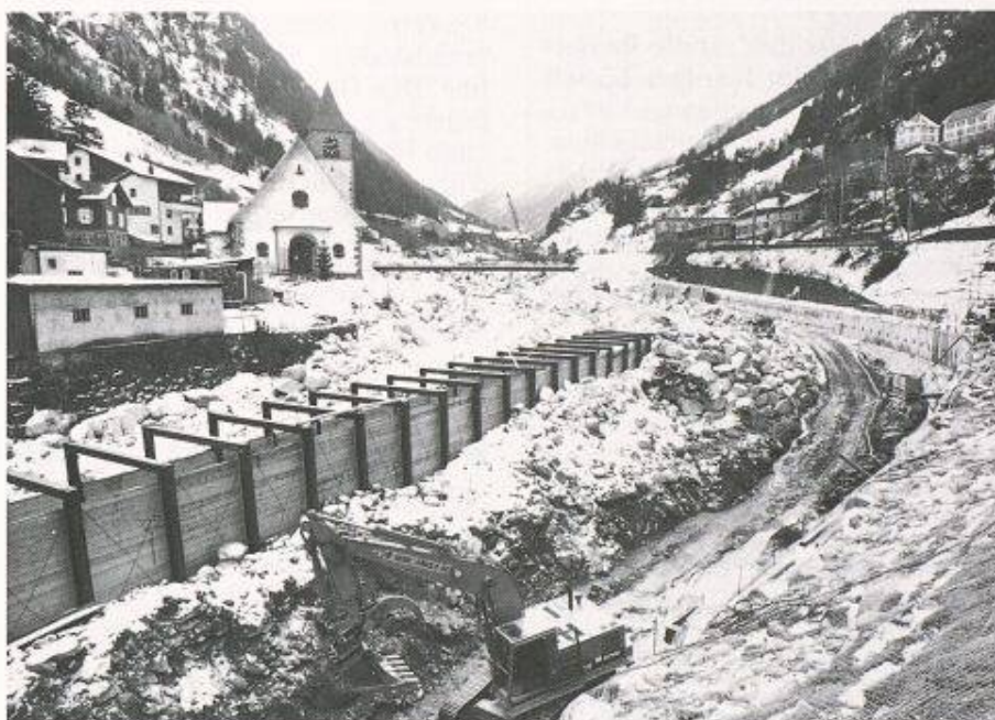
Verbauungsarbeiten am Reussbett bei Gurtellen UR (Bild: Comet)
